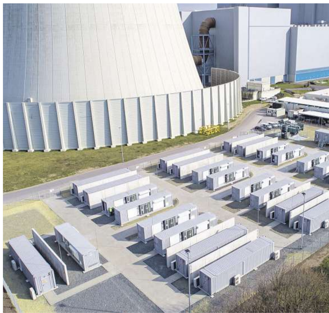
Ukládání energie Největší evropské bateriové úložiště elektřiny (50 MW) je v německé Lužici v hnědouhelné elektrárně Schwarze Pumpe. Za jeho vybudováním stojí skupina EPH Daniela Křetínského. Foto: LEAG
