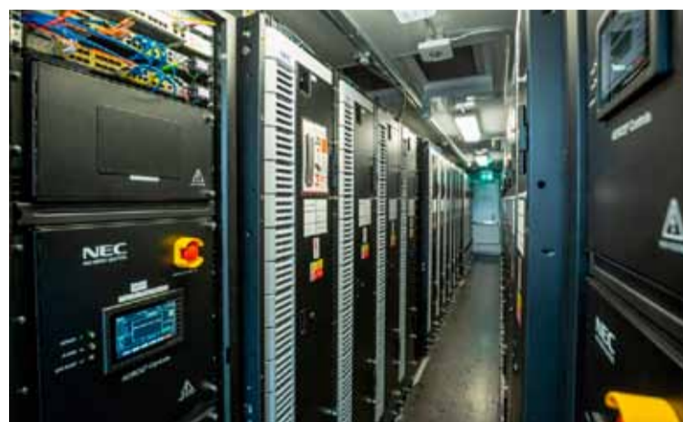
Interiér bateriové jednotky v Tušimicích
