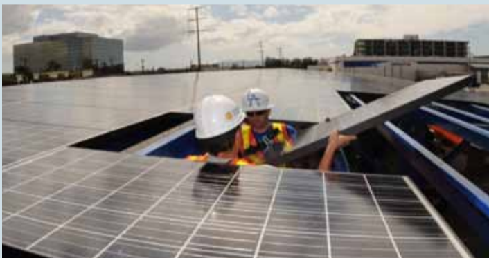
Instalace fotovoltaických panelů
