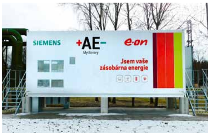
Celý bateriový úložný systém SIESTORAGE je usazen v kompaktním kontejneru, vedle kterého je umístěna transformátorová skříň
